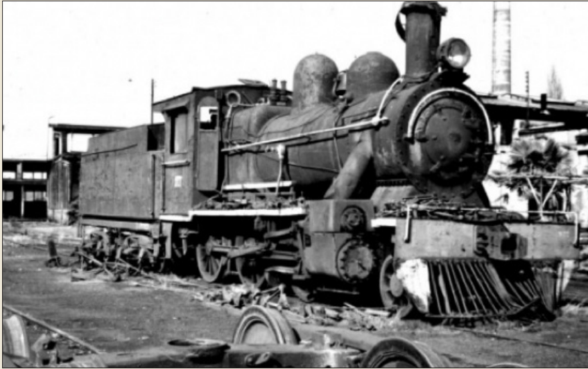
Patio de máquinas de San Rosendo.
