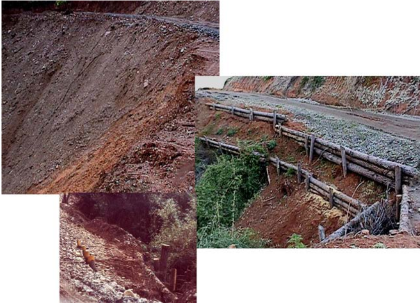
Figura 12.3. Control de la erosión, del arrastre de sedimentos y de los desmoronamientos en caminos forestales mediante programa de mantenimiento.
