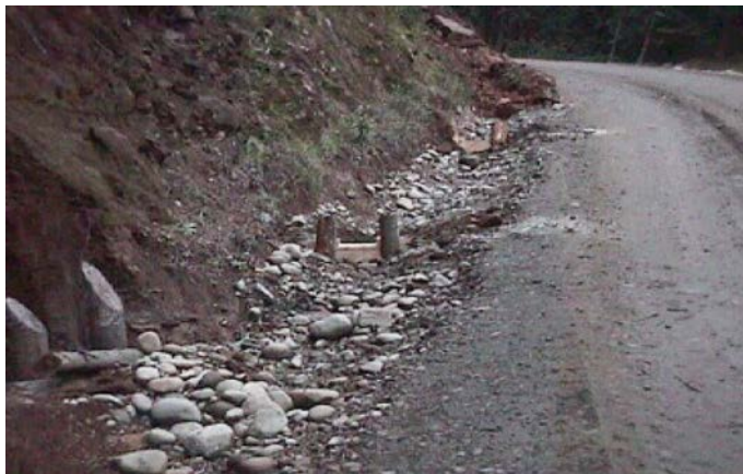
Figura 12.1. Preservación de la calidad del agua en predios forestales mediante construcción de alcantarillas.
